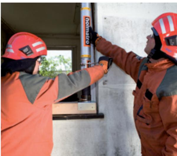
L'étais fileté manuel est utilisé pour étayer une fenêtre. Il peut être sécurisé à l'aide d'une clé à ergots (voir image ci-dessous).
