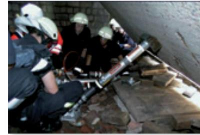
Stabilisation et levage de structures effondrées avec un système hydraulique à verrouillage par contre-écrou.
