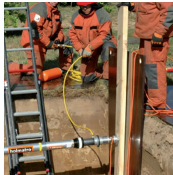
Les étais pneumatiques à verrouillage automatique conviennent parfaitement à un étayage à distance pour sauvetage en tranchée.
