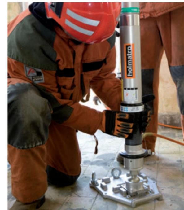
Étai pneumatique à verrouillage par contre-écrou utilisé comme étai manuel pour étayer un bâtiment.
