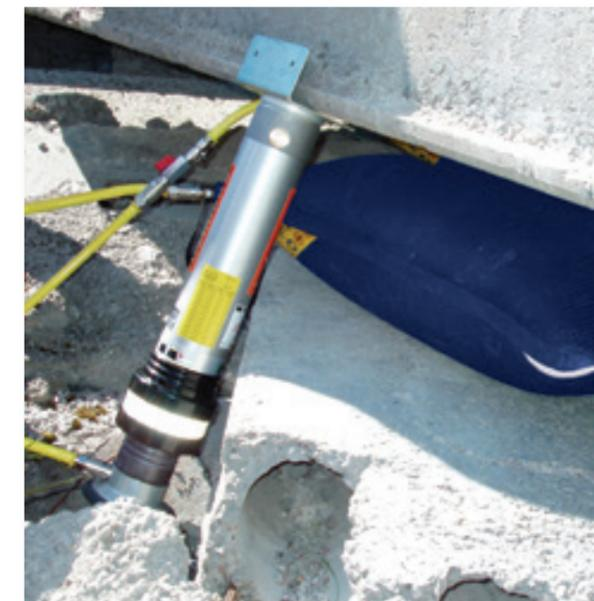
Étai à verrouillage automatique utilisé pour seconder un coussin de levage.
