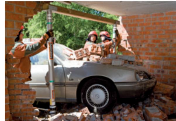
Positionnement des deux étais avec têtes de soutien de poutre et une poutre, pour stabiliser un bâtiment. Les étais hydrauliques à verrouillage par contre-écrou seront minutieusement déployés par une pompe manuelle.
