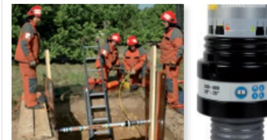
Le verrouillage de ce système (auto-lock) est automatique, permettant un étauage à distance : le processus par lequel un étau est positionné dans une zone sécurisée et ensuite déployé à distance par pression pneumatique ou hydraulique. Par conséquent, seuls les étais possédant un système de fonctionnement pneumatique ou hydraulique peuvent être équipés de ce système de verrouillage automatique.
