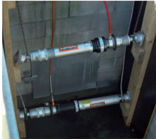
Étaillage à distance avec étais à verrouillage automatique.
